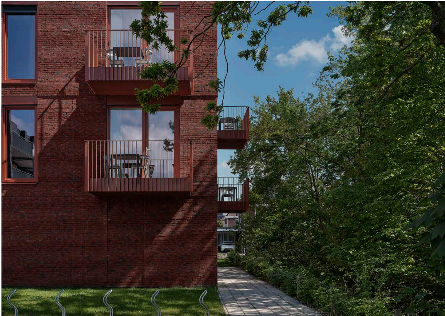
De circulaire gevel is ‘geklikt’ waarbij de bakstenen na demontage gemakkelijk hergebruikt kunnen worden. Het gebouw heeft vanuit elke hoek een andere beleving. De afwezigheid van een voeg versterkt de kleur van de baksteen.
