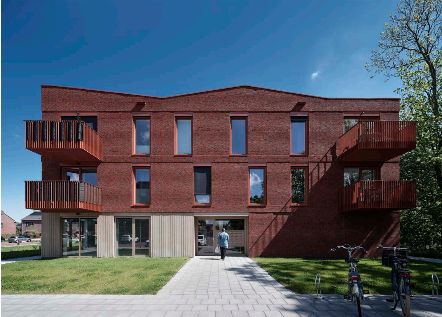
De circulaire gevel is ‘geklikt’ waarbij de bakstenen na demontage gemakkelijk hergebruikt kunnen worden. Het gebouw heeft vanuit elke hoek een andere beleving. De afwezigheid van een voeg versterkt de kleur van de baksteen.
