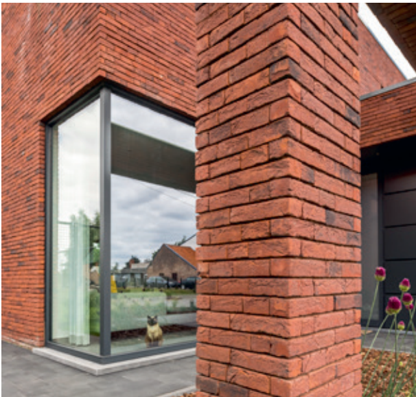
Verlijming geeft een meer monolithisch geveluiterlijk.
