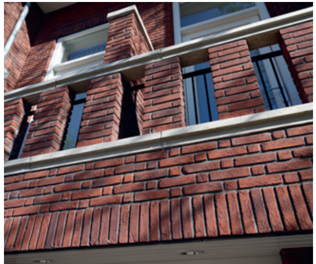
Metselverband aangepast aan de smalle kopmaat
