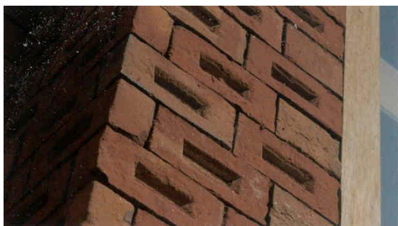
Klamp gelijmd metselwerk
