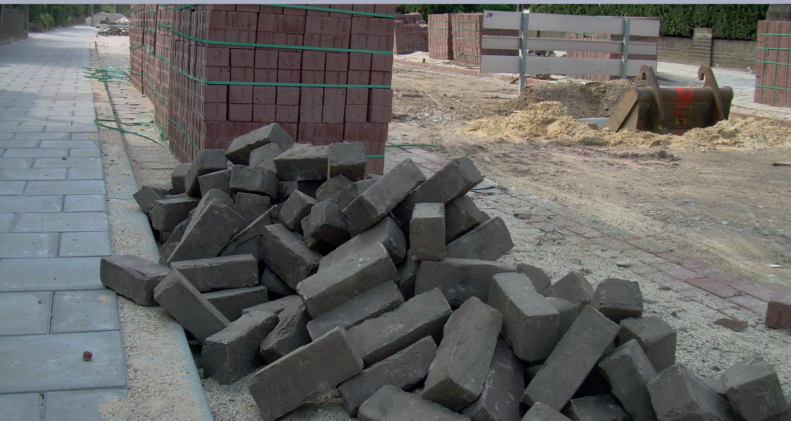
De mate van hergebruik straatbaksteen = 90%. Voorbeeld van trede R3-Re-use
