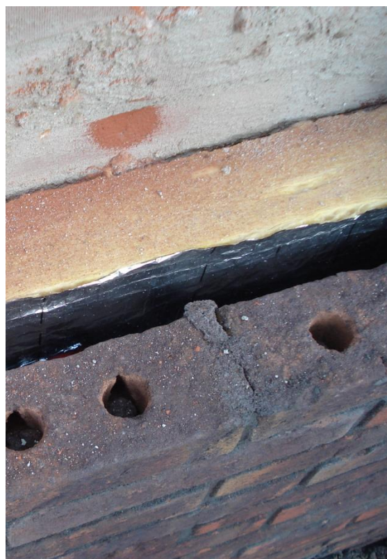
Gebruik van smalle baksteen bij renovatie
