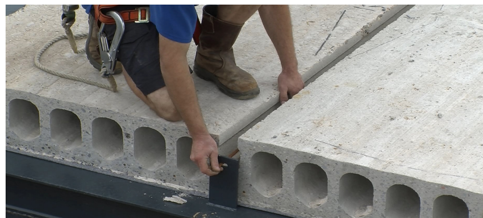
Figuur 50. Montage kanaalplaatvloer
