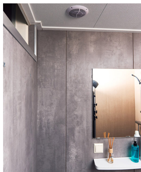
Figuur 16. klikwanden en sanitair
