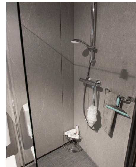
Figuur 18. klikwanden en vloer
