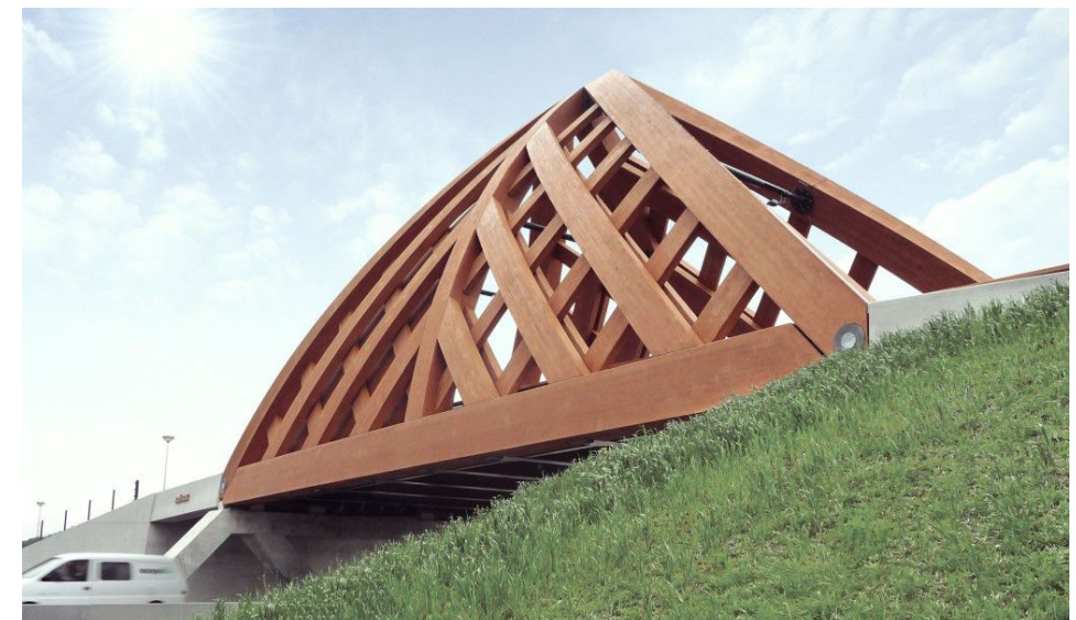
Figuur 90. Accoya brug in Sneek
