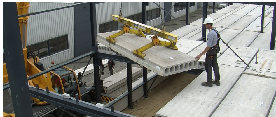
Figuur 49. Montage kanaalplaatvloer
