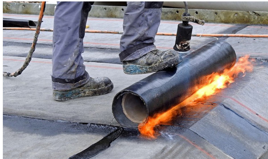
Figuur 78. aanleggen van bitumen
