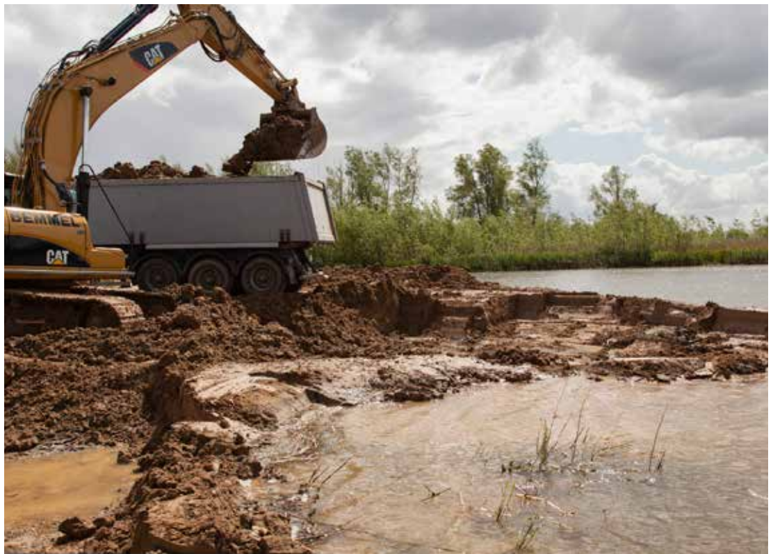
Bij slot Loevestein in het Munnikenland werden in het kader van het project Ruimte voor de Rivier maatregelen genomen om een groot gebied langs de Waal te beschermen tegen hoogwater. De winning van klei - als zichzelf vernieuwende grondstof - speelde een belangrijke rol in dit project (KGK 3 2017: Munnikenland; kleiwinning en riviergeveiligheid)
