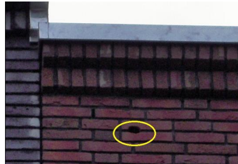
Nestelsteen toegepast in de gevel
