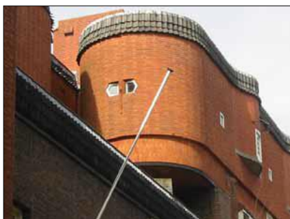
Figuur 2. Fraai voorbeeld van rondlopend metselwerk in Amsterdamse School architectuur.
