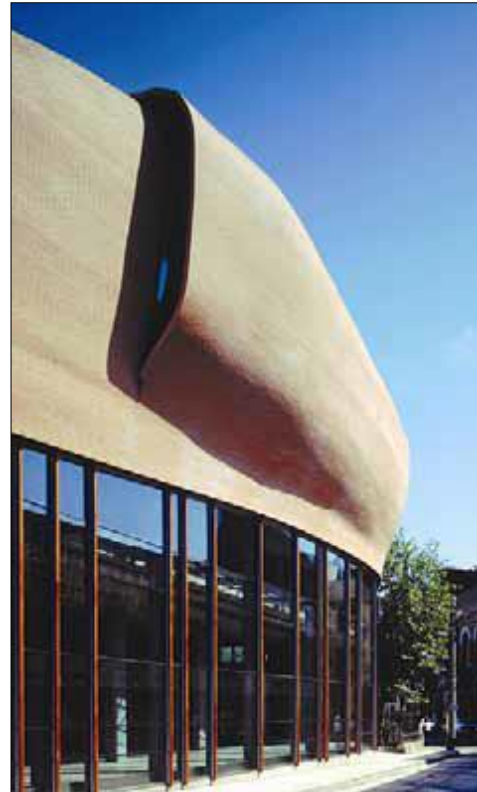
Figuur 3. Gekromd metselwerk Cork Museum (Ierland) door architect Eric van Egeraat
