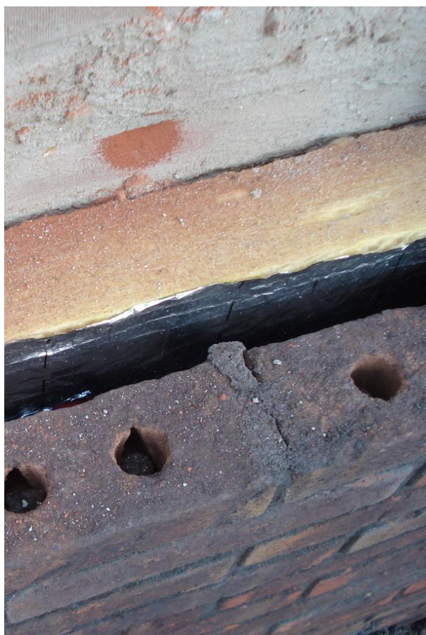
Gebruik van smalle baksteen bij renovatie
