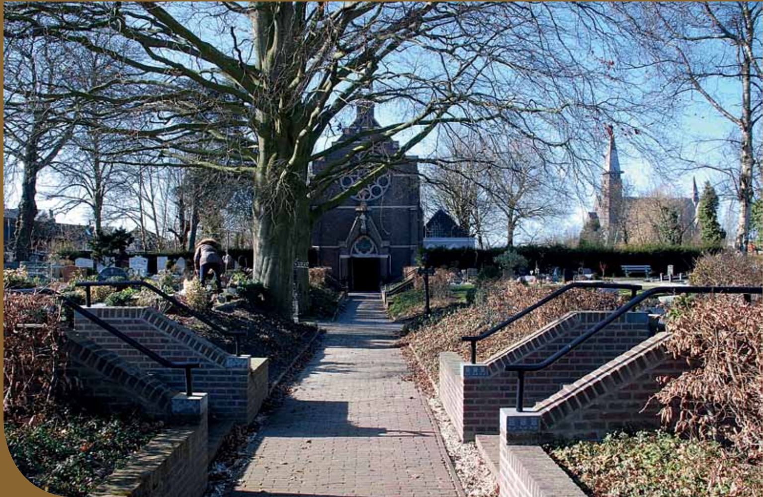
Leiden, renovatie Kruisweg begraafplaats Zijlpoort
