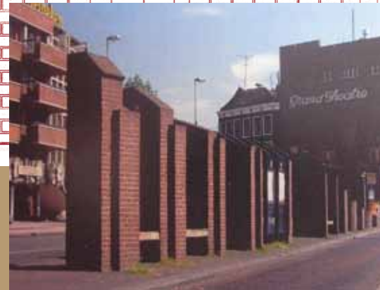
Groningen, zit- en wachtgelegenheid (inmiddels afgebroken)
